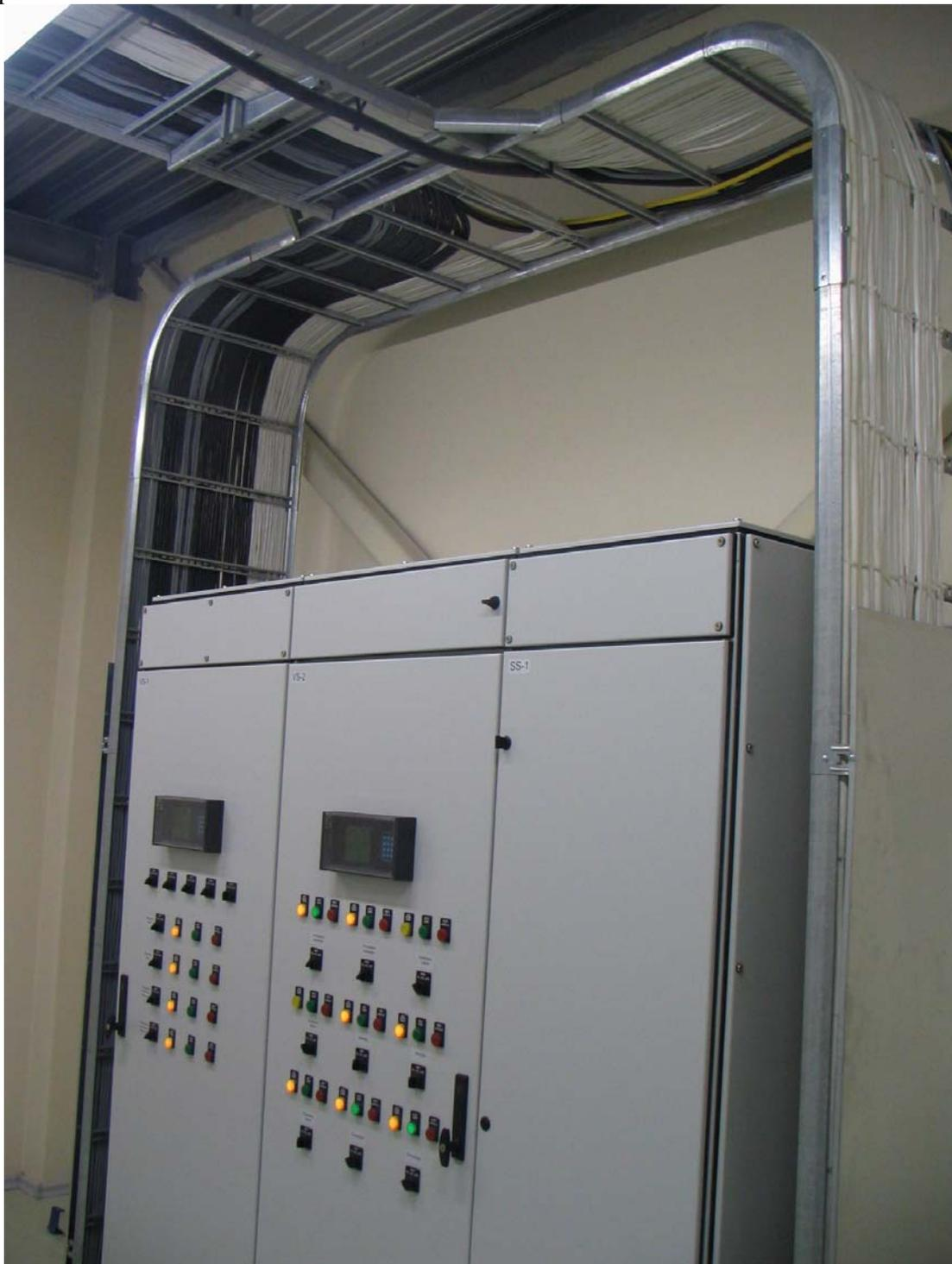
Установленные на объекте фильтрации и обезжелезования ПЛК полностью управляют его работой. Параметры, определяющие алгоритм работы ПЛК задаются оператором посредством SCADA системы из диспетчерского центра. Основными функциями ПЛК являются контроль за работой фильтров и входным потоком, аэрация и
