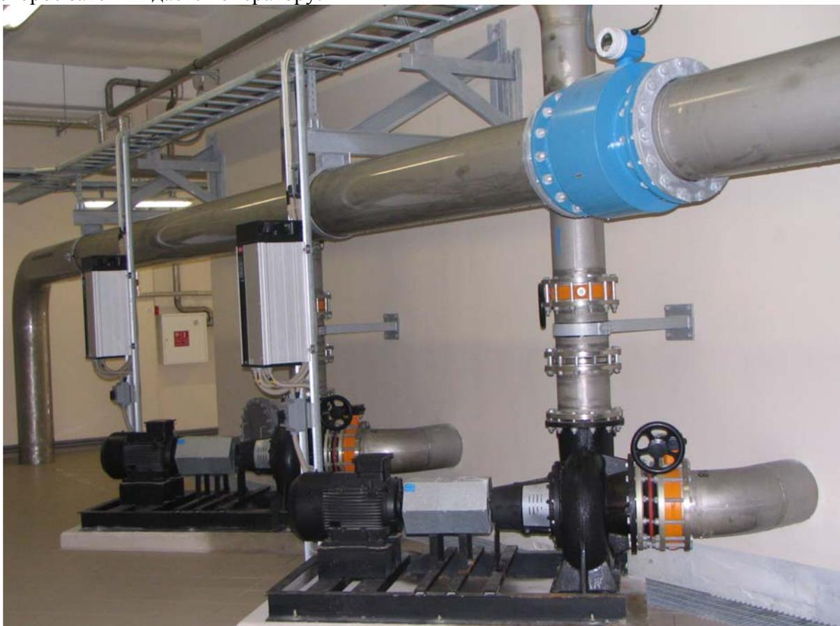
Также, как и на артезианских скважинах, на объекте фильтрации и обезжелезования установлены частотные преобразователи для управления воздуходувками и промывочными насосами. Программирование частотных преобразователей осуществляется аналогично.
